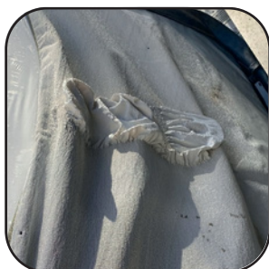
Boursoufflure sur la couverture
